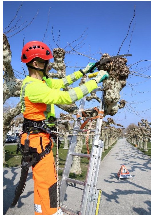
Le système d'assurage de la position de travail (baudrier avec ceinture et longues de maintien en position de travail) permet de libérer les deux mains pour travailler tout en restant sécurisé.
